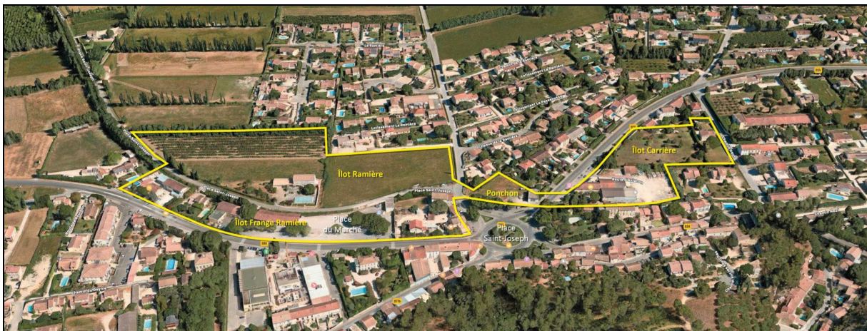
Vue aérienne sur le site
